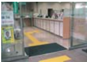
視覚障がい者誘導用点字ブロック(安来支店)
